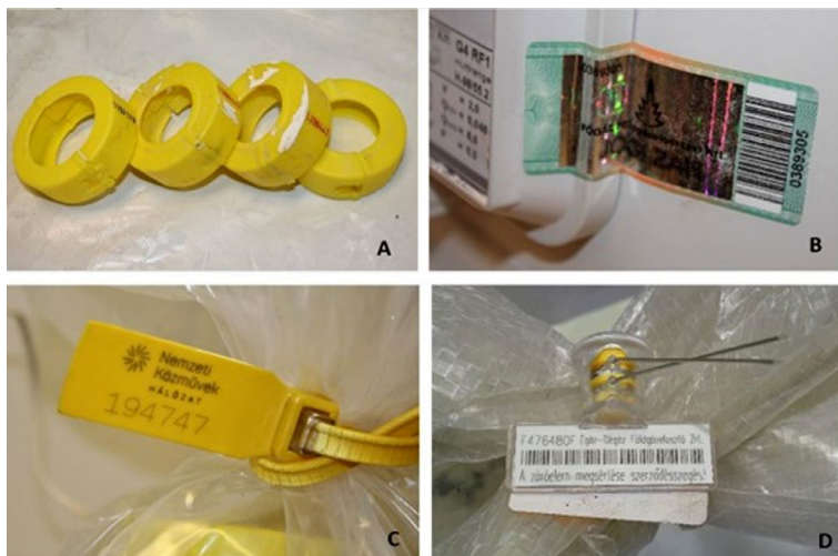
71. ábra – A: hollander plombák, B: szolgáltatói matrica, C: befűző plomba, D: zsinóros plomba. (a szerző saját felvételei)
